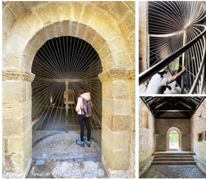
Ermita de Santiago, en Ruesta (Foto: Sebastián Arquitectos)
