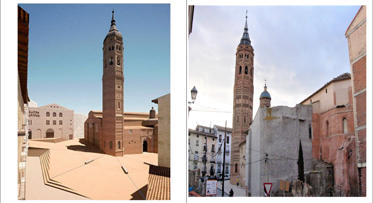
El proyecto plantea la eliminación de barreras arquitectónicas de la plaza con una construcción de plataforma única
