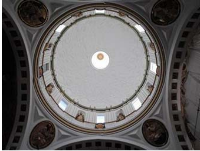
Imagen de la cúpula de la Colegiata de Santa María de Calatayud rehabilitada
